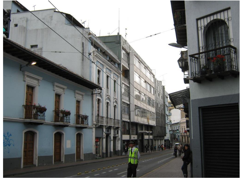
EDIFICIOS RACIONALISTAS NO INTEGRADOS AUSENCIA DE PARAMETROS DE INTEGRACIÓN
