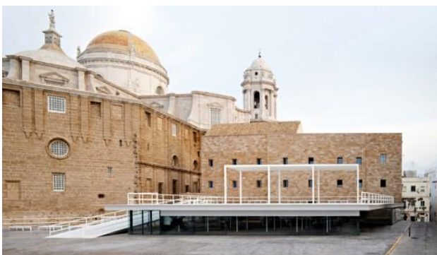
Integración de arquitectura contemporánea en un espacio urbano residual, utilización de volumetrías y planos horizontales, respetando las características espaciales del espacio de intervención. Integración por contraste. Cádiz España
