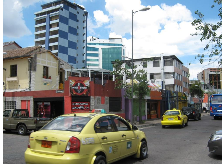
TRAMO J.L. MERA ENTRE FOCH Y CALAMA NO INTEGRADO POR INVASIÓN DE LA TRAZA URBANA Y PÉRDIDA DE IDENTIDAD
