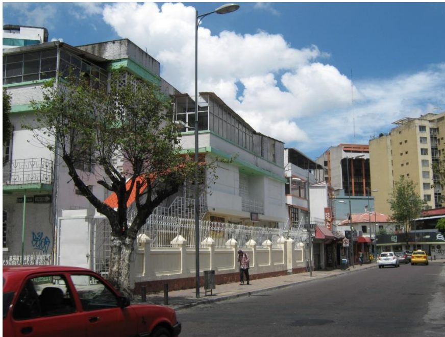
TRAMO J.L.MERA ENTRE FOCH Y CALAMA NO INTEGRADO POR INVASIÓN DE LA TRAZA URBANA E INTERVENCIONES CAÓTICAS EN LA TRAMA
