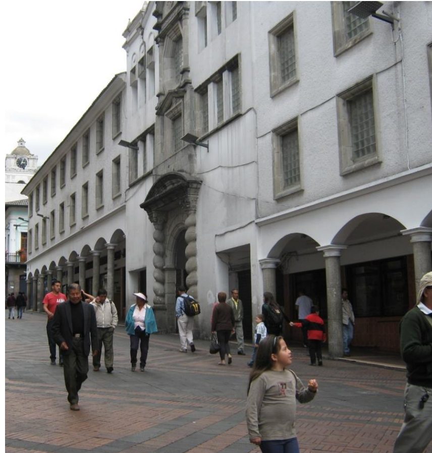
EDIFICIO RACIONALISTA AUSENCIA DE PARAMETROS DE INTEGRACIÓN (INTENCIÓN DE ANALOGÍA)
