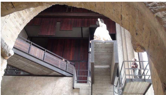
Integración: Integración parcial de componentes contemporáneos orientados a refuncionalizar la edificación. Se mantiene la tipología original. Integración por contraste. Castelvecchio Verona- Italia
