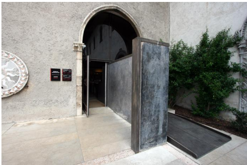
Reestructuración parcial con nueva arquitectura: complementación de componentes arquitectónicos contemporáneos dirigidos a relacionar los elementos arquitectónicos preexistentes. Integración por contraste.
