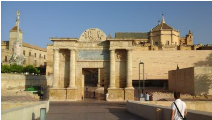
Reestructuración de un espacio público de valor patrimonial, Integración de arquitectura contemporánea como componente del conjunto arquitectónico. Integración por contraste formal y mimesis de textura y materiales. Integración con nueva arquitectura por analogía. Córdoba España
