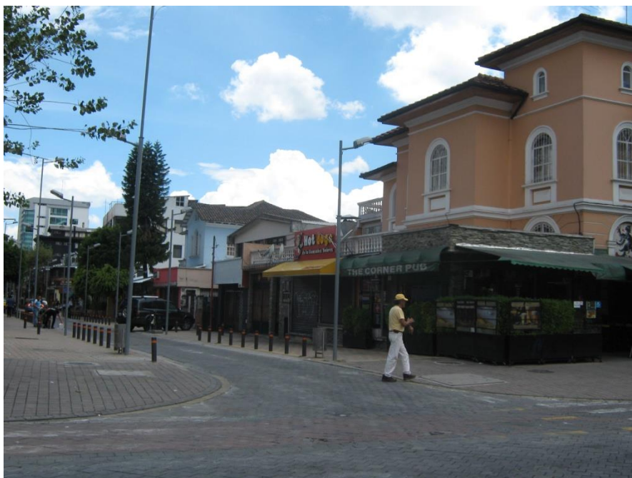
TRAMO RODRÍGUEZ ENTRE R. VICTORIA Y J.L. MERA NO INTEGRADO POR INVASIÓN DE LA TRAZA URBANA
