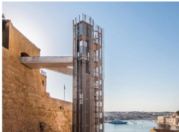
Reestructuración parcial con nueva arquitectura: complementación de un componente arquitectónico dirigido a relacionar la edificación histórica con el espacio público. Integración por articulación y enlace. Nueva York. USA
