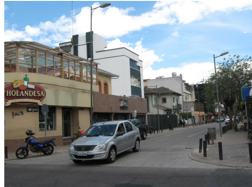
TRAMO PINTO ENTRE J.L.MERA Y R. VICTORIA NO INTEGRADO POR INVASIÓN DE LA TRAZA. REPOSICIÓN RACIONALISTA DESUBICADA Y PÉRDIDA DE IDENTIDAD
