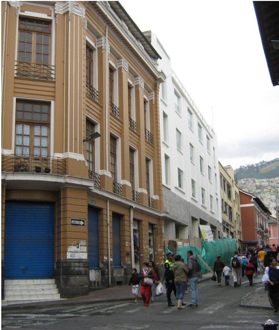
EDIFICIOS RACIONALISTAS AUSENCIA DE PARAMETROS DE INTEGRACIÓN (LOS DE ENLACE)
