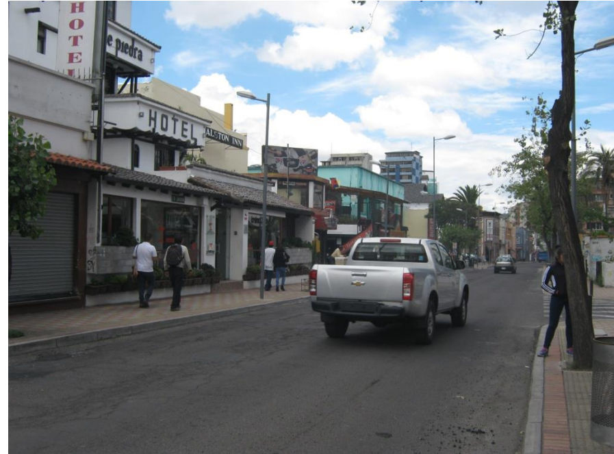
TRAMO J.L.MERA ENTRE VEINTEMILLA Y WILSON NO INTEGRADO POR INVASIÓN MUY INTENSA DE LA TRAZA Y PÉRDIDA TOTAL DE LA IDENTIDAD.
