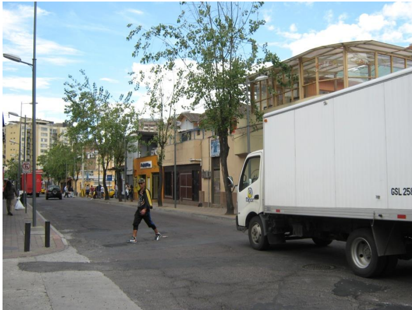
TRAMO J.L.MERA ENTRE FOCH Y PINTO NO INTEGRADO POR INVASIÓN DE LA TRAMA Y DE LA TRAZA. PÉRDIDA DE IDENTIDAD
