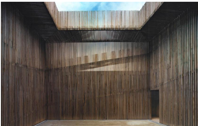
Reestructuración parcial integración de nuevos bordes en una edificación existente. Integración por, contraste forma. Torre del Homenaje Granada España
