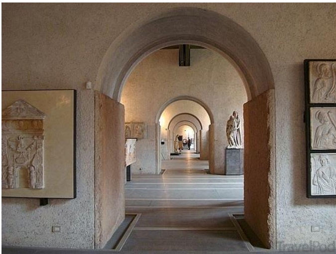
Integración: conservación, complementación parcial de componentes contemporáneos orientados a recuperar la espacialidad y materialidad de la edificación. Se mantiene la tipología original. Integración por mimesis. Castelvecchio Verona- Italia
