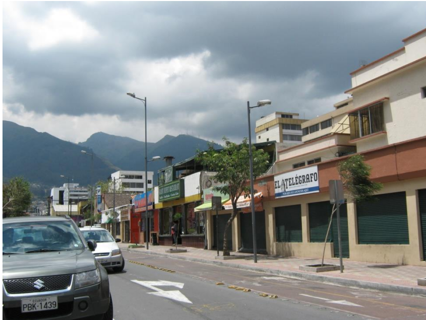
TRAMO CARRIÓN ENTRE R.VICTORIA Y J. L. MERA NO INTEGRADO POR INVASIÓN DE LA TRAZA URBANA Y PÉRDIDA DE IDENTIDAD DE LA EDIFICACIÓN; ALTERACIÓN DE LA TRAMA
